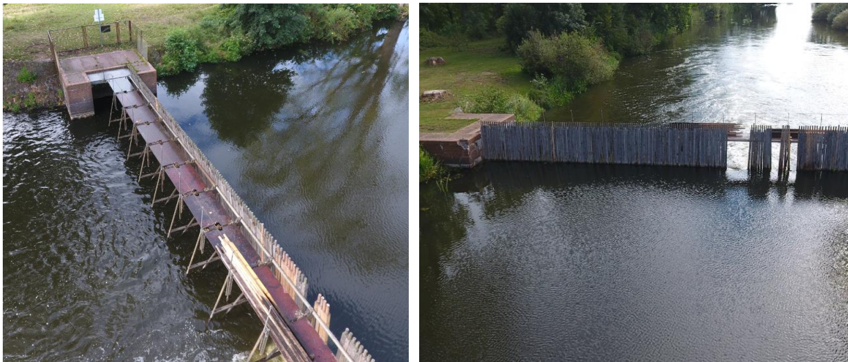
Abbildung 4 – Ansicht der Wehranlage von Unterwasser und von Oberwasser
